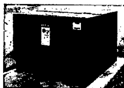
شکل ۲-۱۴ ترانسفورماتور پدمانتد تکفاز
