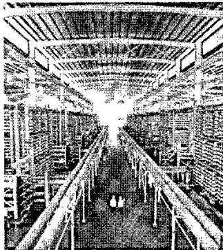
شکل ۸-۱۳: یک دستگاه اسمز معکوس به ظرفیت تولید ۳۱۸,۵۰۰,۰۰۰ لیتر آب شیرین در روز (سنگاپور)
