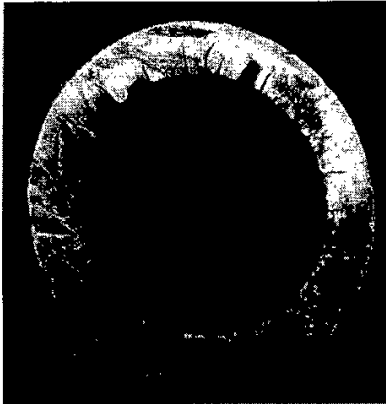
شکل ۶.۲۷. مقطعی از لوله که ترک‌ها در آن مشاهده می‌شود.
