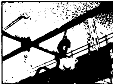
شکل ۱۴.۱۴ قلاب کردن قرقره‌ی زنجیر به داربست
